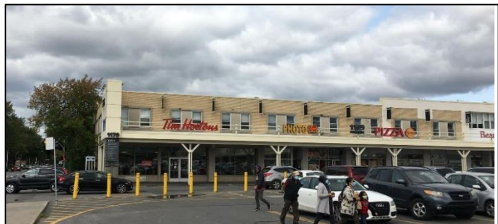
Tim Horton à côté de la station Côte-Vertu Crédit photo : Islem Bendjaballah
